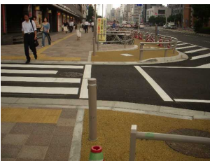
カーブが急な巻き込み部
