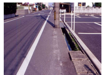
中央線を消去した対面通行道路(愛知県稲沢市)
