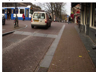
トランジットモールを横切るプラトー (アムステルダム)
