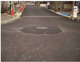
ハンプに応用できそうなマンホールの蓋(名古屋)
