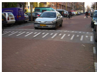
住宅地のハンプ (アムステルダム)
